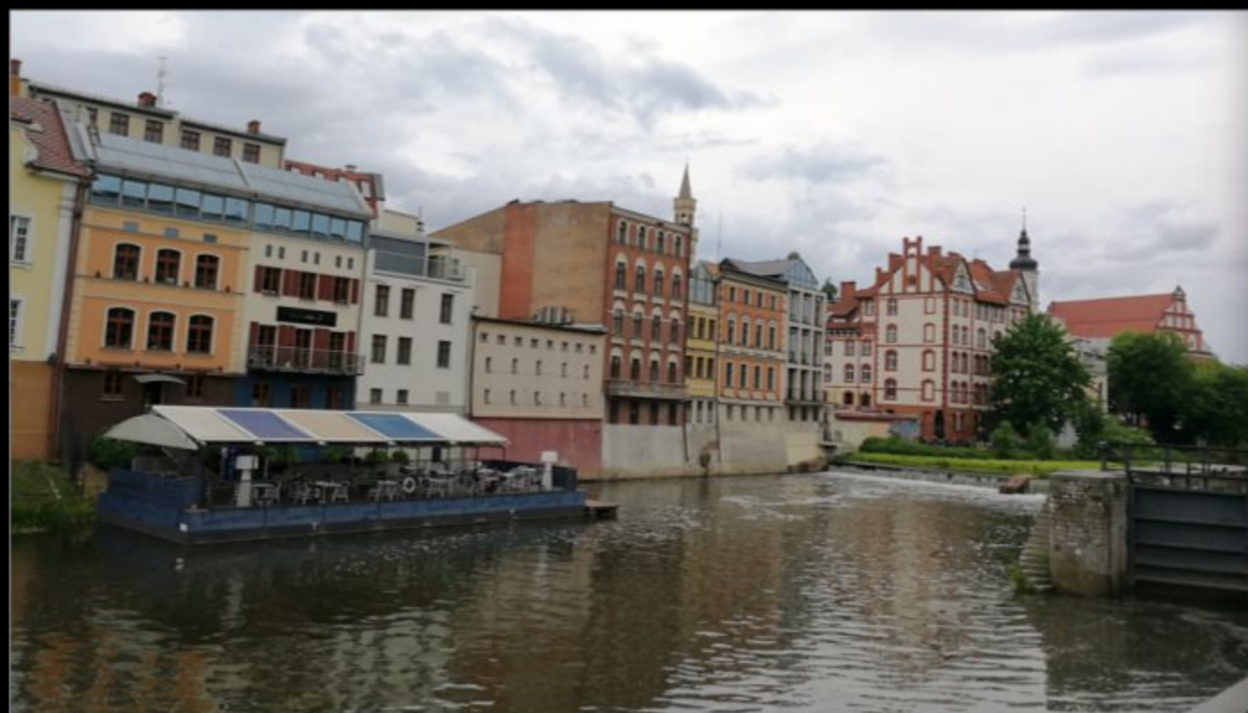
Mit großen Wehr und Schleuse
