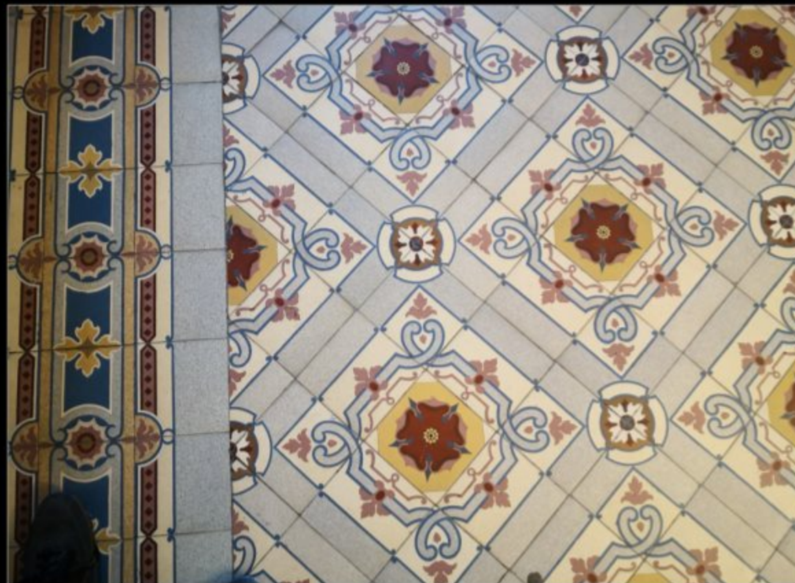
Stuckdecke und Bodenfliesen im Eingangsbereich
