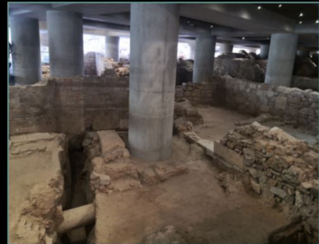
Das Museum ist auf Stelzen über einem Grabungsfeld gebaut worden
